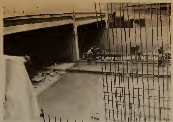
Invert Section pour completed.
